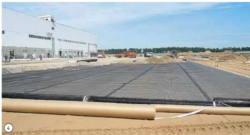
Применение геосеток для армирования подстилающего слоя
