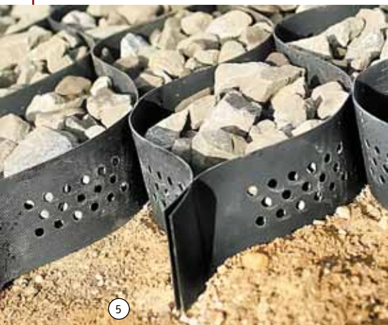
Применение объемных георешеток для армирования подстилающего слоя
