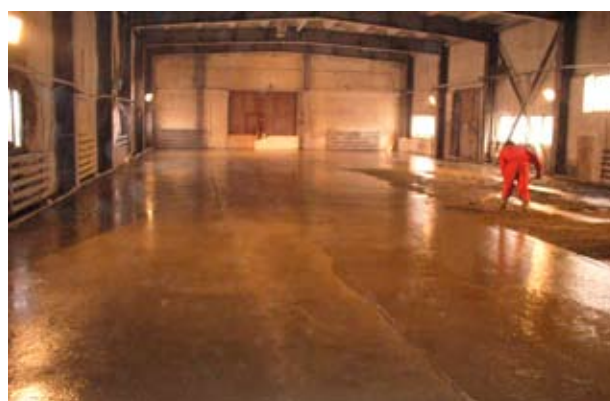
Рис. 2. Заливка фибробетона Pic. 2. Fibre-reinforced concrete placing
